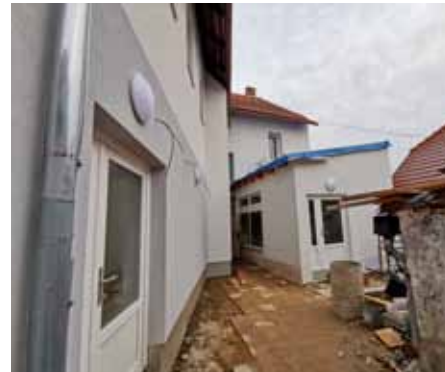
Pohled do vnitřního traktu
